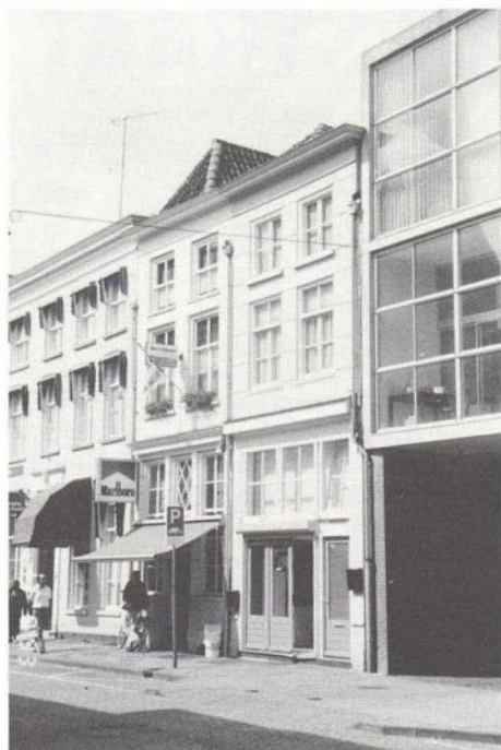
Afb. 1 Hinthamerstraat 102 en 104, zoals thans nog aanwezig (Foto Bouwhistorische en Archeologische Dienst van de gemeente 's-Hertogenbosch, BAD).
