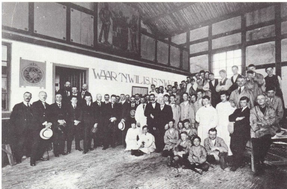
Afb. 4 Interieur van de loods in 1921, toen er de Noodschool was gevestigd. De schilderijen zijn uitgevoerd naar ontwerp van Huib Luns (GAHT, Hist.-Top. Atlas nr. 4825).
