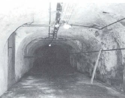
Afb. 2. Tongewelfde kelder onder de gang. (Foto: BAD)
