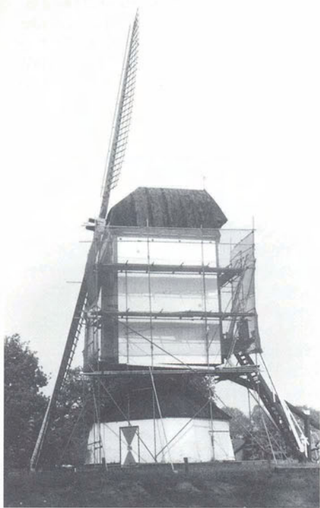
Afb. 7. De molen tijdens de restauratie van 1996. Foto genomen na het aanbrengen van de linkerzijwand. (Foto: BAD)
