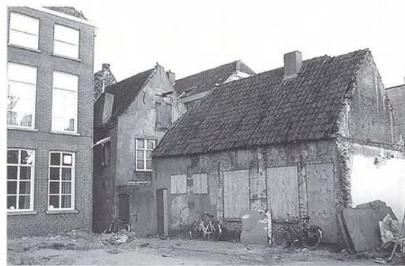
Afb. 1: Enkele van de laatst overgebleven kameren aan het Peter de Gekstraatje (Foto: BAM)
