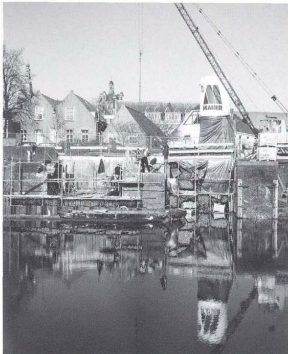
1999: Restauratiewerkzaamheden in volle gang aan de Grote Hekel.
