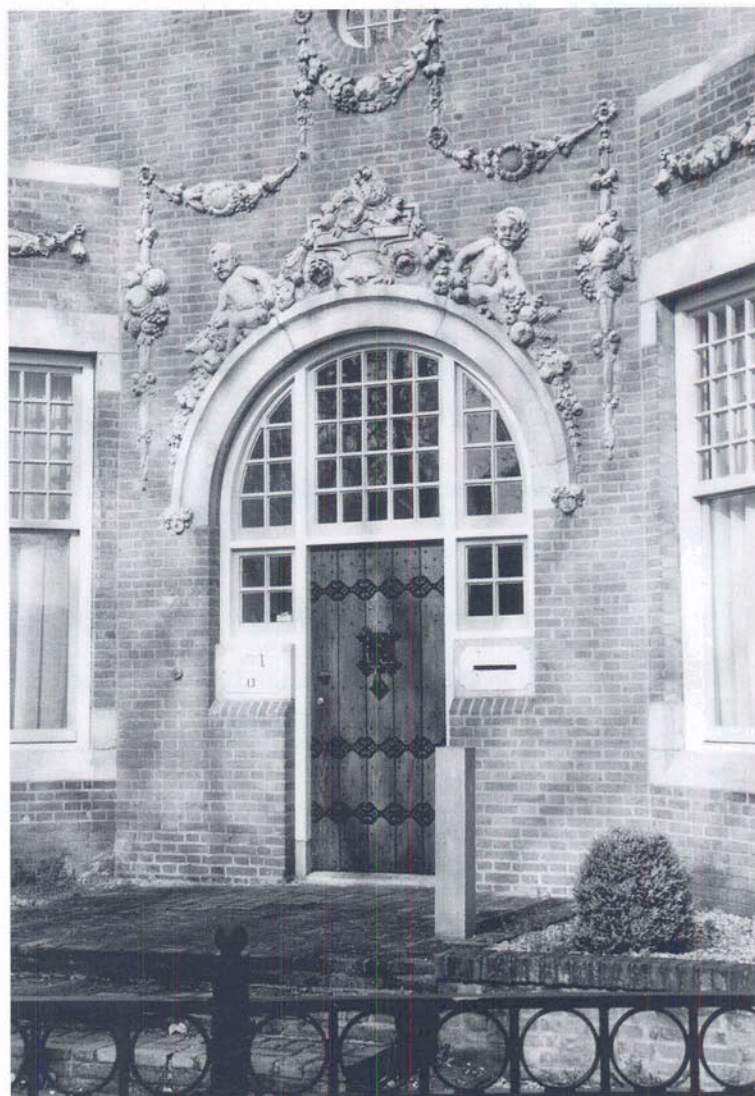
Detail natuurstenen reliëf boven de voordeur van de villa van Dr. Daniëls. (Foto: BAM)
