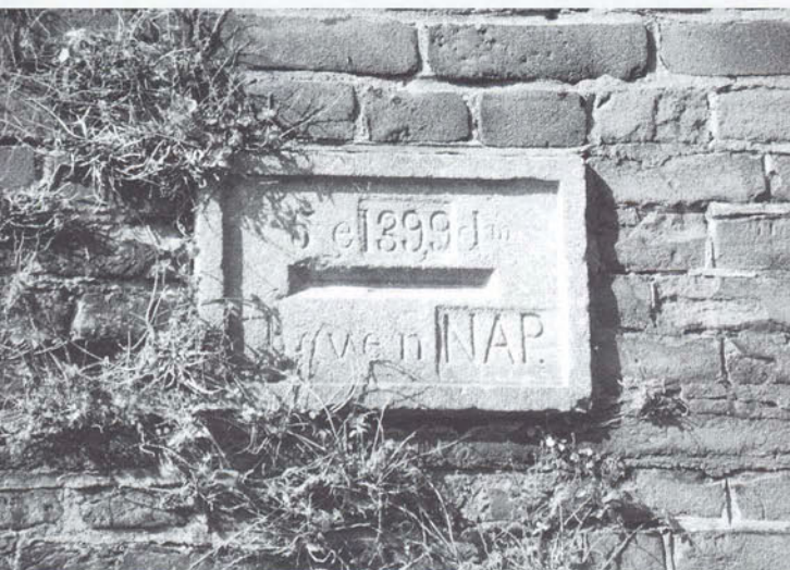
In de hardstenen peilmerksteen uit 1865 zijn de letters AP veranderd in NAP. Ook zijn de hoogtecijfers '59' gewijzigd in '39,9'. Door het verwijderen van de oorspronkelijke letters en cijfers ontstonden in het hardsteen verdiepte vakjes die nog goed zichtbaar zijn. (Foto: BAM, 1999)
