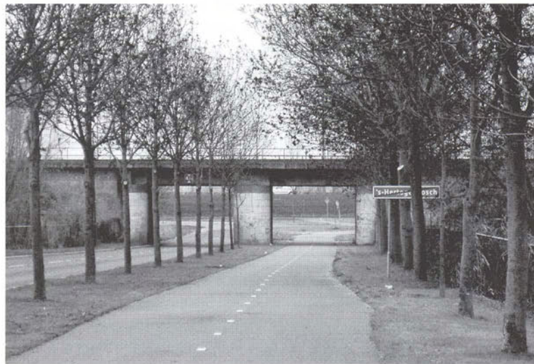
Afb.10. De voormalige sluis uit 1870 onder de spoorlijn naar Utrecht, nu verkeerstunnel. Gefotografeerd naar het westen. (Foto: BAM)
