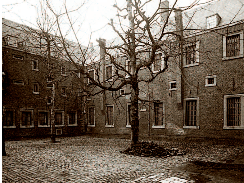
De noordwesthoek van de grote binnenplaats. Een opname van Pierre Weijnen uit 1912. (Stadsarchief, reproductie)
